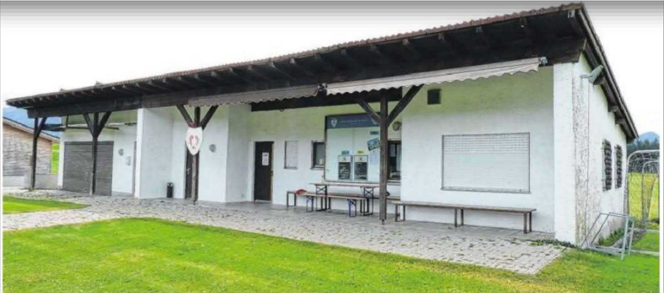
Das in die Jahre gekommene Clubheim des TSV kann nicht mehr saniert werden und wird im Herbst abgerissen. Ein neues, geräumigeres Domizil für die Sportler wird auf dem Grundstück gebaut. Fotos: Martina Gast
